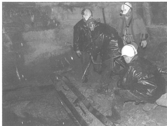
Přikování poškozeného nosníku.
