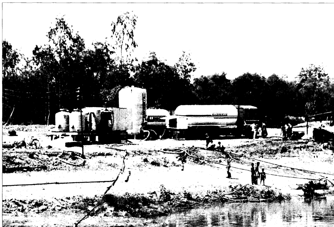
Inertizace dusíkem v Indii, technologie PSA, kapalný dusík, (foto Voráček 2000)
