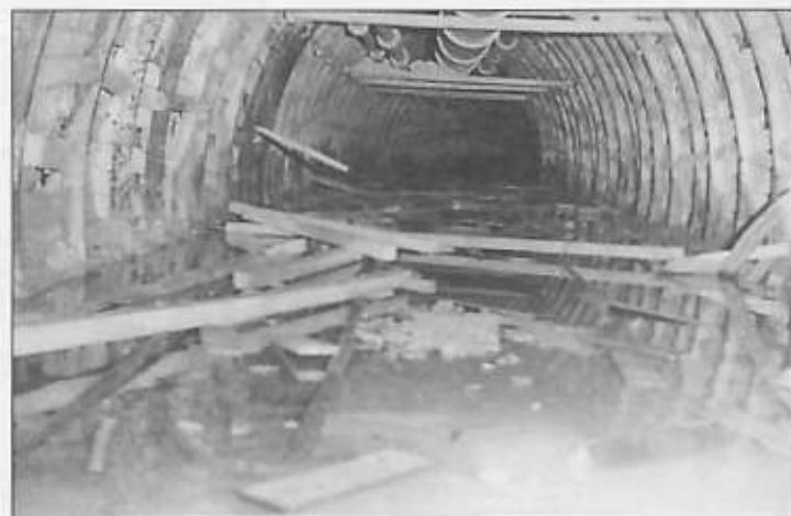
▲ ČÁSTEČNĚ ROZMETANÁ PRACHOVÁ UZÁVĚRA VÝBUCHEM PŘI UZÁVĚRÁNÍ ENDOGENNÍHO POŽÁRU NA DOLE BARBORA V KARVINĚ 11. 1. 1971
