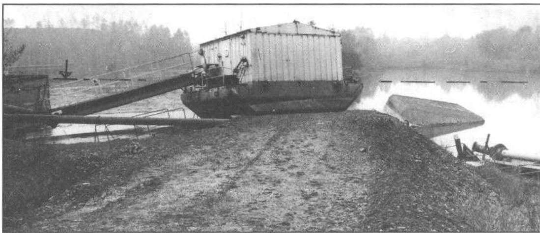
SITUACE NECELY TÝDEN PO ZÁSAHU (původní výška kulminující hladiny vyznačena).
