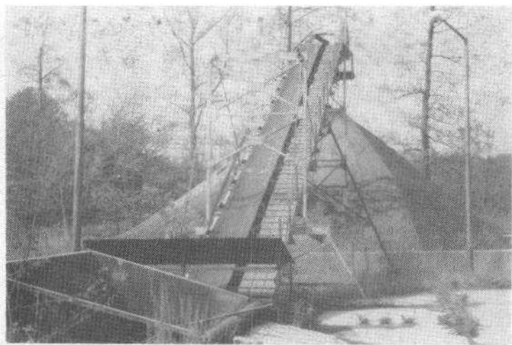
SKLÁDKA POPÍLKU A SPLAV
